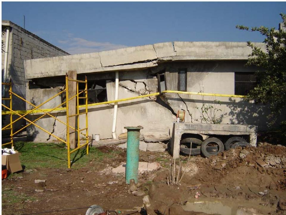
*Figura 2.2. Casa afectada en San Pedro Totoltepec, Estado de México, por la subsidencia asociada a la disminución del almacenamiento del acuífero y la consiguiente pérdida de presión en los estratos inferiores, lo que produce colapsos en superficie.*
